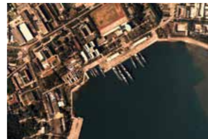
三亚港口航拍图像 Aerial images of Sanya harbour
